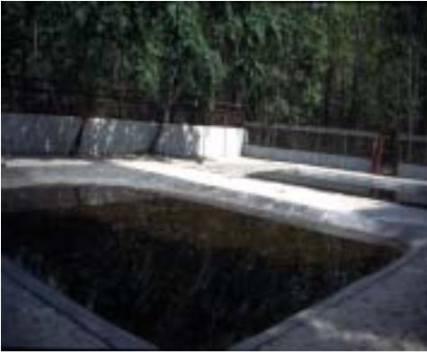
Abb. 16: Neu fertiggestellte Schildkroetenstation in Kasarah
